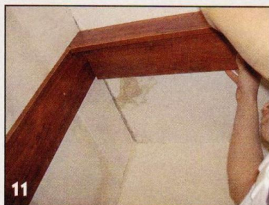
11 Последовательно закрепил элементы каркаса. При наличии аккумуляторного шуруповёрта сделать это несложно.
