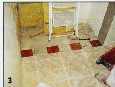
3 Из отходов производства выкроил 4 квадратные опоры, в каждую из которых вкрутил по два самореза. Головки саморезов, выступающие над опорами, выставил так, чтобы...
