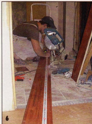
6 На боковой стойке нужно подготовить выборки под накладную панель каркаса.
