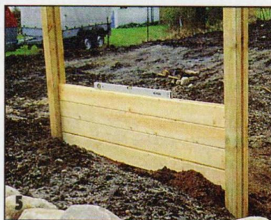
5 Доски просто вставляют в пазы стоек. Здесь важно выверить по уровню первые ряды досок.
