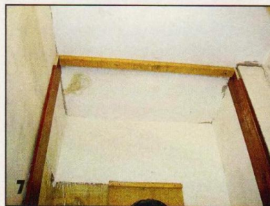
7 Между несущим бруском и стенами заведены боковые стойки каркаса. Всё готово для окончательного монтажа рамы.
