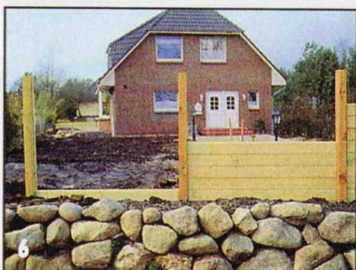
6 Установив несколько досок (до уровня намеченного земляного вала), вплотную к ним отсыпают гравий, а затем и землю.
