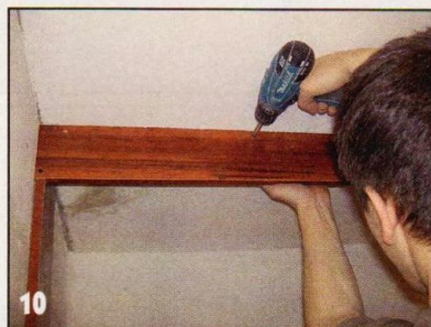
14 Нижний рельс разместился на соответствующей перемычке дверной рамы.
